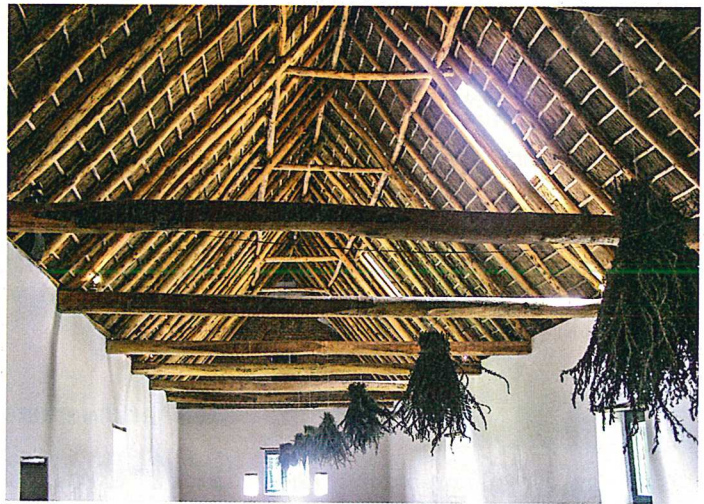
Die Innenansicht auf ein reetgedecktes Dach in Südafrika, bei dem jeder einzelne Halm sichtbar bleibt.
