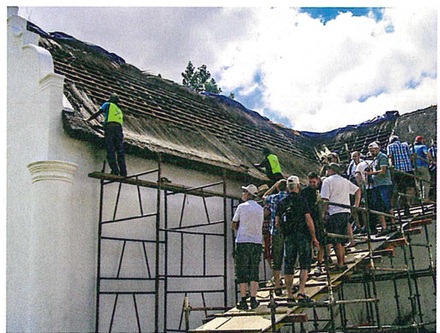
Baustellenbesichtigungen in der Region um Kapstadt boten ideale Möglichkeiten, fremde Decktechniken kennen zu lernen.
